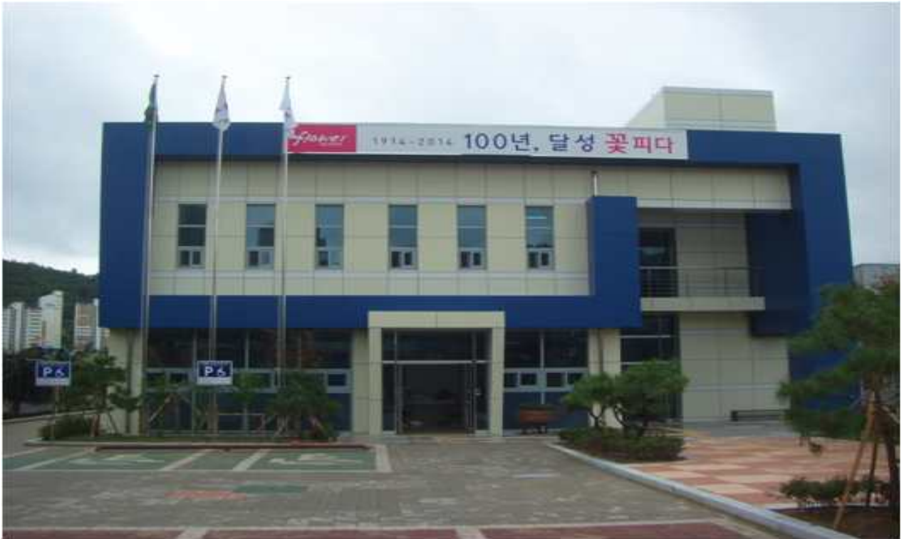
(서재출장소 외부 전경)
